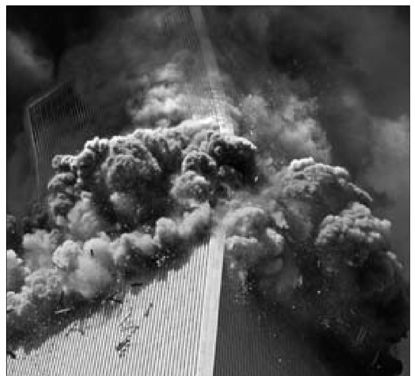
Las explosiones de la demolición controlada proyectaron los materiales de la fachada y la estructura a decenas de metros.
